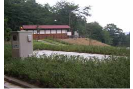
装置の全景(手前の施設)
