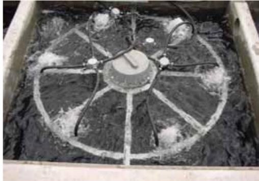
広域町村し尿処理施設からの処理水を浄化して、蛍の住む水路の水源に使用しています。高度処理のため、木炭水質浄化装置(5連)が稼動しています。
