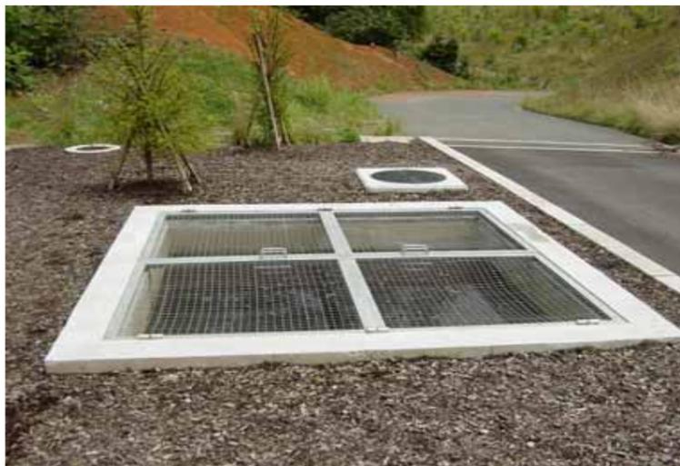
舞鶴PAから出るし尿処理水が周辺の水田に放流されるため、木炭水質浄化装置による高度浄化を行い、水田に与える影響を小さくして放流しています。
