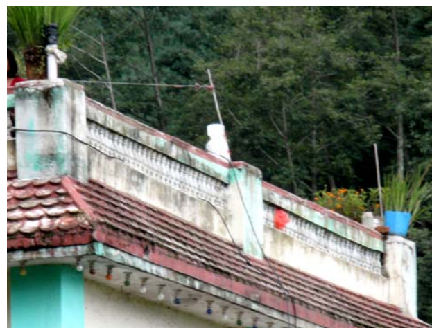
屋上に設置した雨量計
