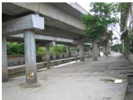
広い河川内空間
