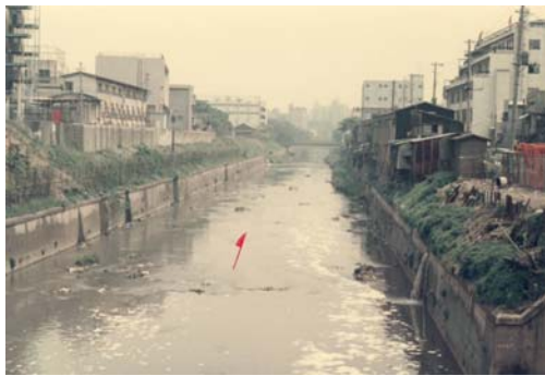
田楽橋より下流を望むー昭和 47 年撮影 (東京都土木技術センター提供)
