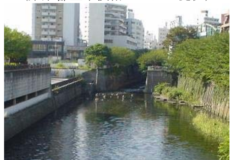
田楽橋より上流を望むー平成18年 JRRN 撮影
