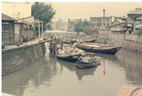
日本橋（現：居木橋）より上流を望むー昭和47年撮影 （東京都土木技術センター提供）
