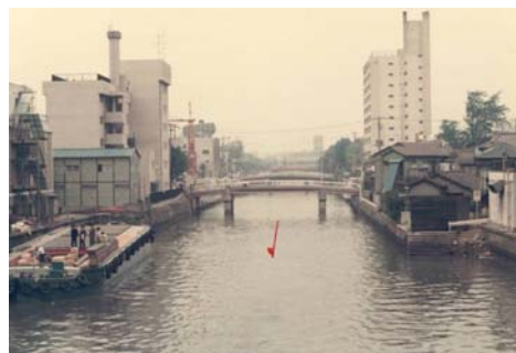
昭和橋より上流を望むー昭和47年撮影 （東京都土木技術センター提供）
