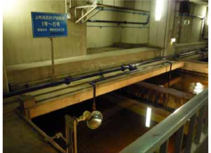
写真 12 砂ろ過設備
