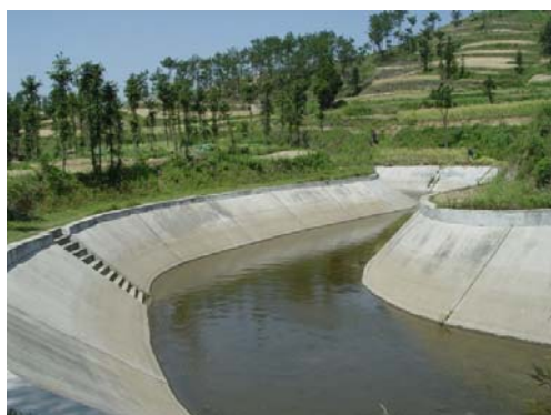
湖北省内の農業用水路（金檀地区） （出典：湖北省水利庁ホームページより）
