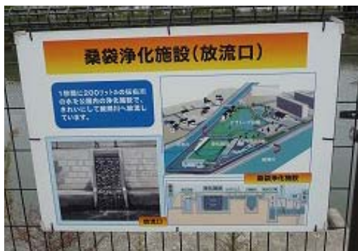
綾瀬川への放流口に設置されている看板 (人頭大の石に付着した微生物による浄化が行われている)
