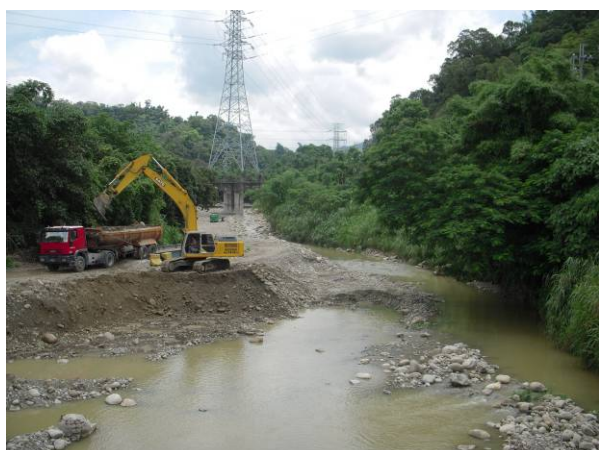
大坑支川床固上流土砂撤去状況（台中）
