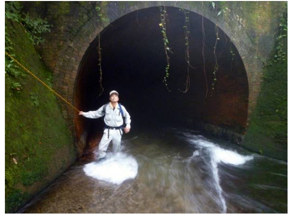
◇写真3 トンネルの上は鉄道です。
