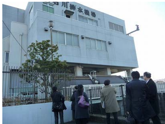
伝右川排水機場
