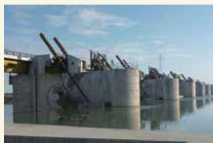
平成23年11月に通水した新しい可動堰
