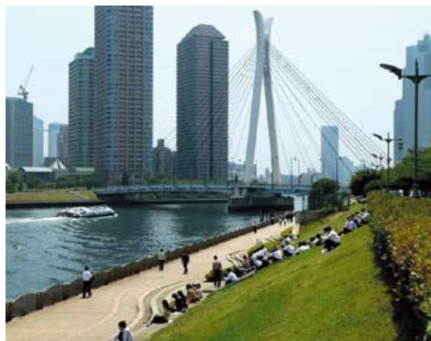
人々の憩いの場となっている水辺空間
