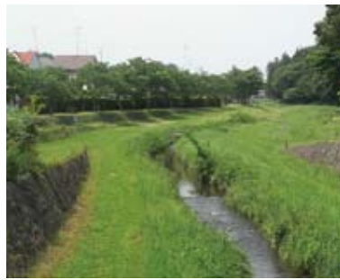
整備後の状況（東山の水辺）
