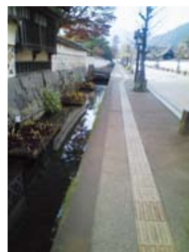
町中の掘割水路
