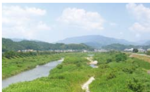
施工13年後の魚の避難場所(平成22年撮影)
