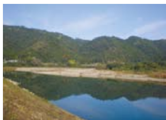
高水敷掘削による自然再生
