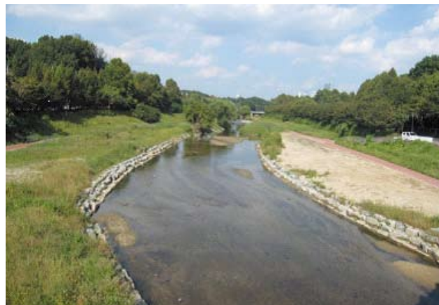
再生された区間を望む
