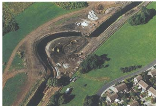
蛇行復元工事の様子
