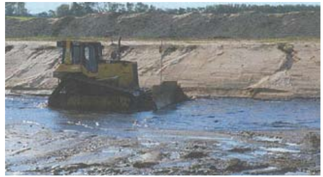
再生工事の様子
