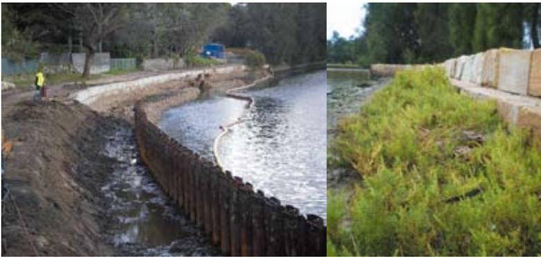
矢板撤去工事と撤去後の護岸（2008年）
